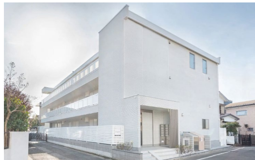
低層ZEH-M促進事業を活用した高性能住宅 現場写真
