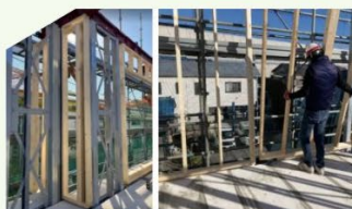
外壁下地パネルの木製化
