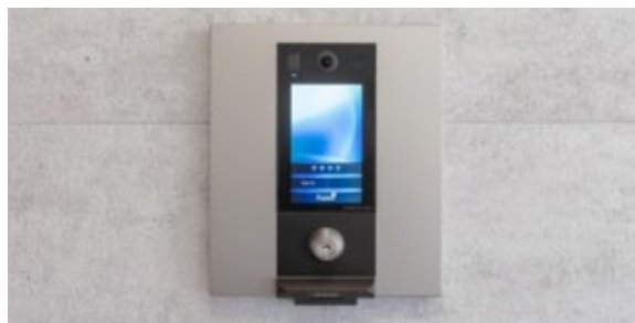
置き配システム機能付集合玄関機 現場写真
