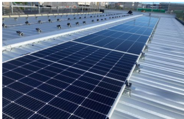
太陽光発電システム 施工現場
