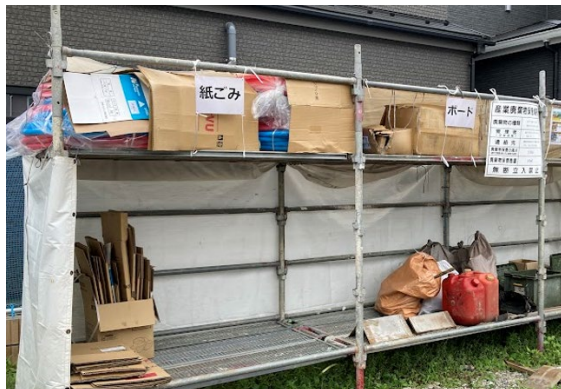
産業廃棄物保管場所 施工現場写真
